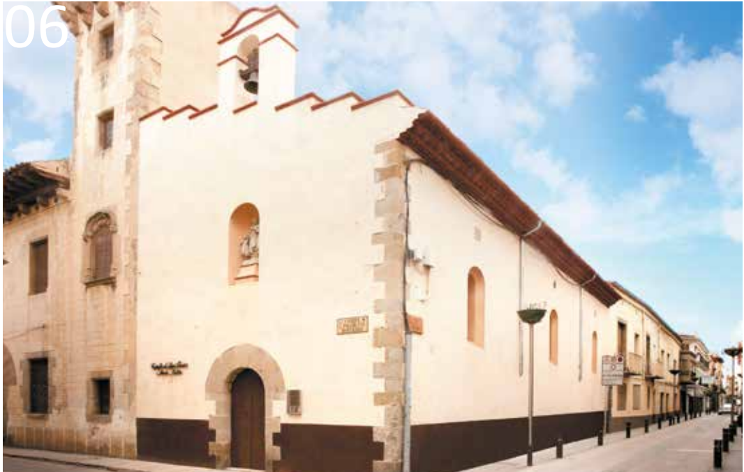
Capella de Sant Quirze i Santa Julita | Capilla de Sant Quirze y Santa Julita | Chapel of Sant Quirze and Santa Julita | Chapelle de Sant Quirze et Santa Julita
